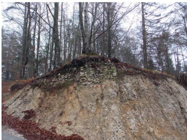
Slika 3. Pogled z glavne ceste proti vzhodu na presek zidu pri Novem Potu (foto: J. Kusetič).
