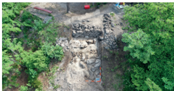
Jeterbenk. Vzhodno pobočje vršne kope s temeljem in zidnim plaščem stolpaste utrdbe in delovno površino za gradnjo, pod katero izdanjajo bloki dolomitne podlage (foto: A. Gaspari).
