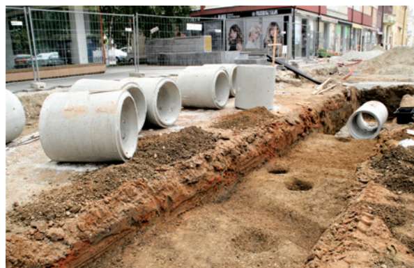
Skupina lukenj za stojke (SE 80, SE 82, 85–90), med katerimi poteka jarek, je bila odkrita ob stavbi Šoping (foto: B. Kerman).
