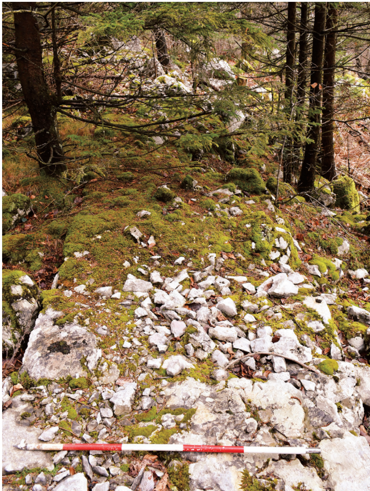
Detajl zidu utrdbe (foto: M. Pergar).
