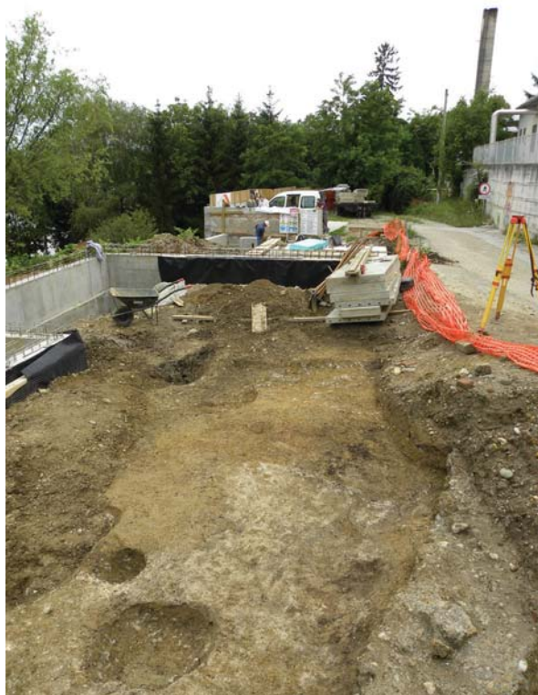
Pogled na izkopno polje, pogled proti severozahodu. Arheologija v letu 2014 – dediščina za javnost
