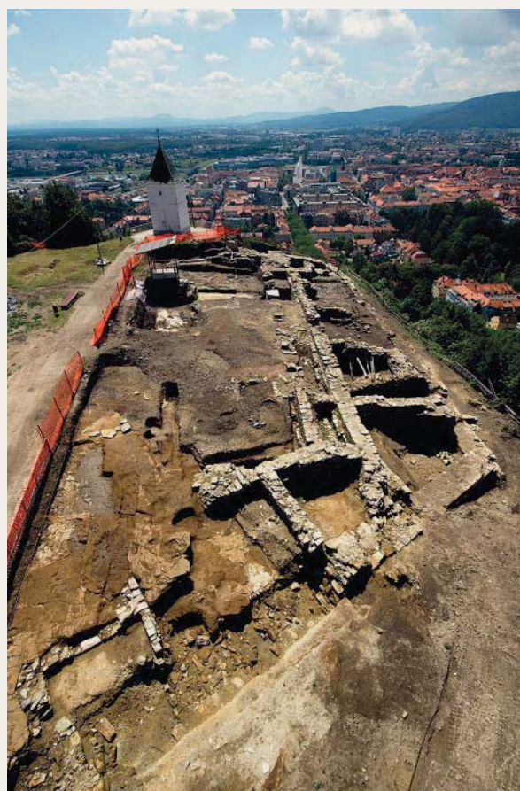
Pogled na temelje zahodnega dela grajskega poslopja, pogled proti jugu (foto N. Grum)
